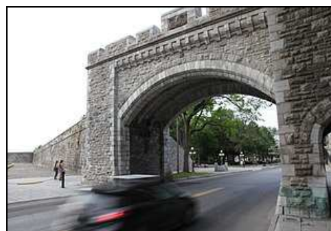
en 2015, vue de l'extérieur après la rénovation
